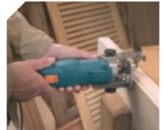
Realización de molduras.
