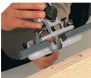
Colocación de pernios con el cabezal ZB93.
