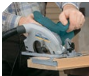
Realizando corte a inglete.
