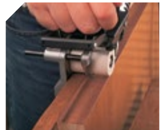
Aplacado de la cara superior del solape.
