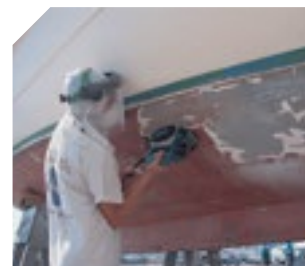
Trabajos de mantenimiento en astilleros.
