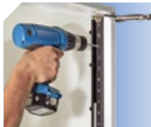
Taladrado para la colocación de estantes.
