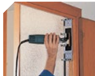
Colocación en el marco (Mod. A093)
