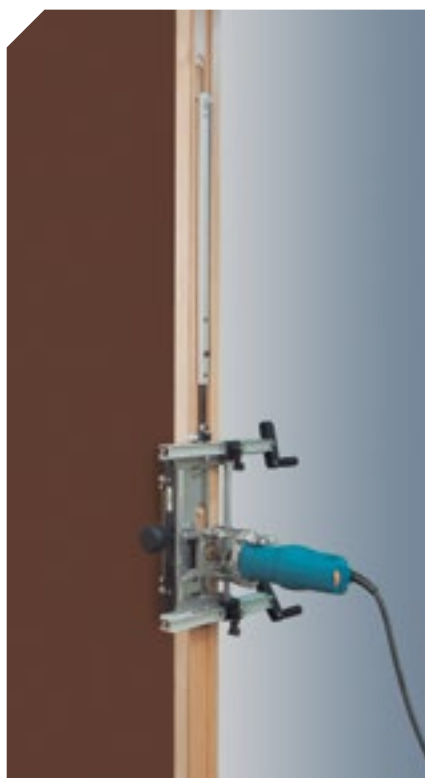
Realización del segundo encaje en el marco.
