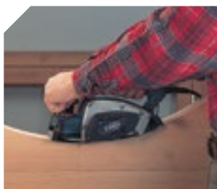
Cepillado de superficies cóncavas.
